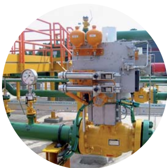
Система HIPPS с двумя реле давления фирмы “Моквелд” на ГИС “Tutong” фирмы “Shell” в Брунее.
