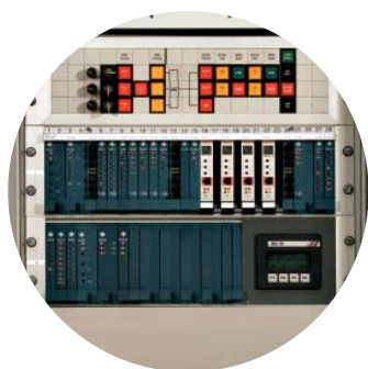
Типичная панель логического вычислительного устройства.
