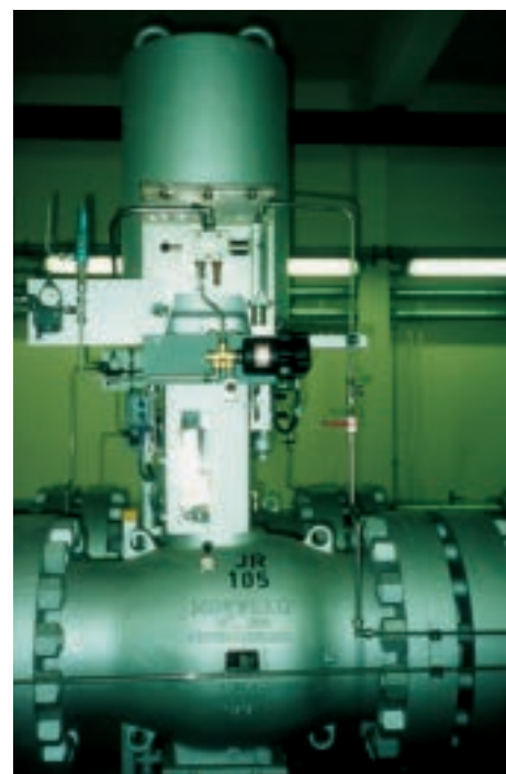
Предохранительный отсечной клапан 16" ANSI 600 на подземном хранилище газа, Германия
