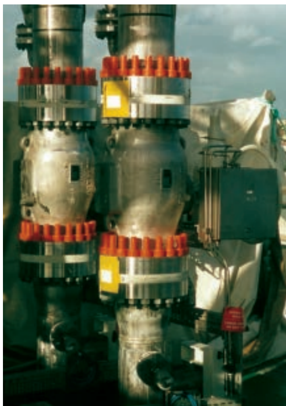
Проходные дроссельные клапаны 10" ANSI 1500 на месте добычи, FPSO, Норвегия
